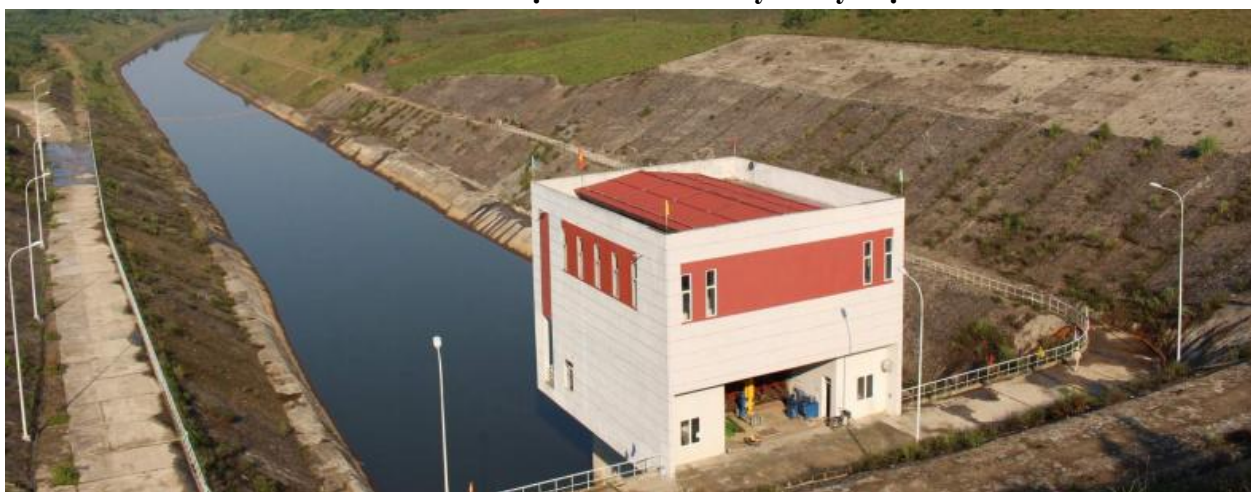
Hình 10: Cửa nhận nước Nhà máy Thủy điện A Lưới
