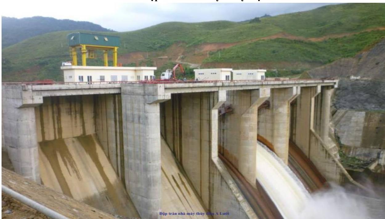
Hình 9: Đập tràn Nhà máy Thủy điện A Lưới
